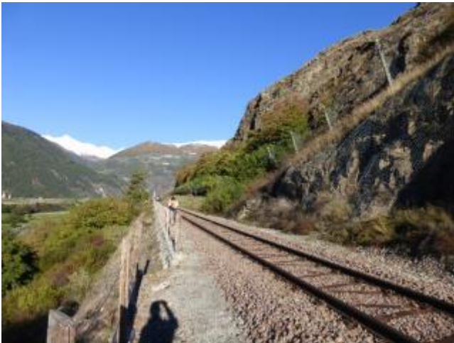
Die Trasse ist in den Fels des Tartscher Bichls eingeschnitten, talseitig wurde aufgefüllt, z.T. sind die talseitigen Böschungen mit Stützmauern gesichert.
