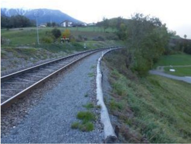
In ersten Teil verläuft die Bahntrasse am Hang, talseitig wurde das Gelände aufgefüllt.
