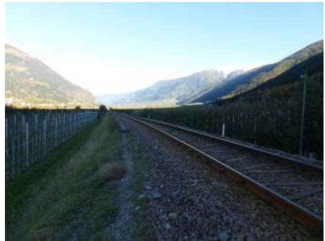
Die Bahntrasse verläuft westlich von Goldrain meist auf einem 1,5–2 m hohen Schüttdamm.
