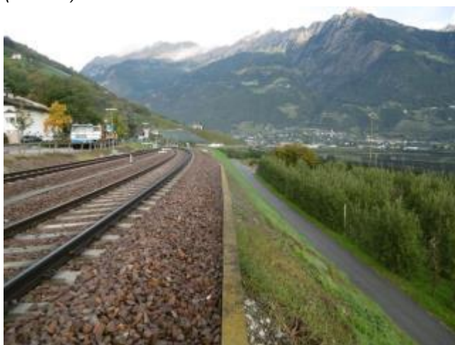
Presso la staz. di Marlengo presenza di terreni di riporto per un'altezza di ca. 5 m. La scarpata in foto é oggetto della "Ristrutturazione stazione di Marlengo".
