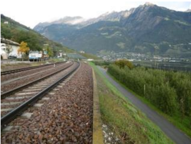
Beim Bahnhof Marling wurde das Gelände rd. 5 m hoch aufgeschüttet. Die im Bild zu sehende Böschung wird im Rahmen des Projektes „Umbau Bahnhof Marling“ saniert.
