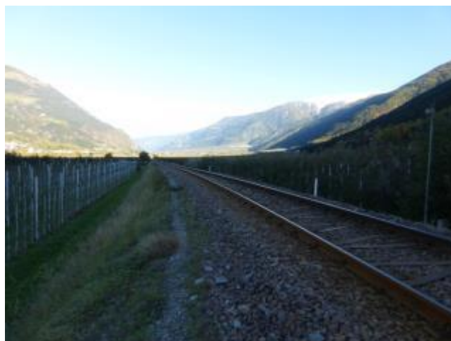
Il tracciato ferroviario si svolge a ovest di Coldrano su un rilevato costituito da materiali di riporto alto 1,5–2 m.
