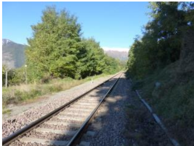
Al lato monte modeste incisioni nei detriti di versante, al lato valle terreni di riporto; profondità del substrato roccioso non nota.
