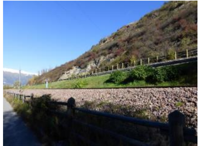
Die Trasse verläuft zum Teil am Hangfuß, hier werden Alluvionen von Hangschutt überlagert (km 85,0 und 85,8).
