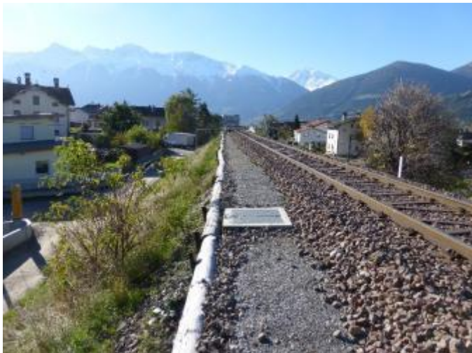
Nell'area abitata di Sluderno il tracciato ferroviario si svolge per ca 300 m su un rilevato alto 7–8 m
