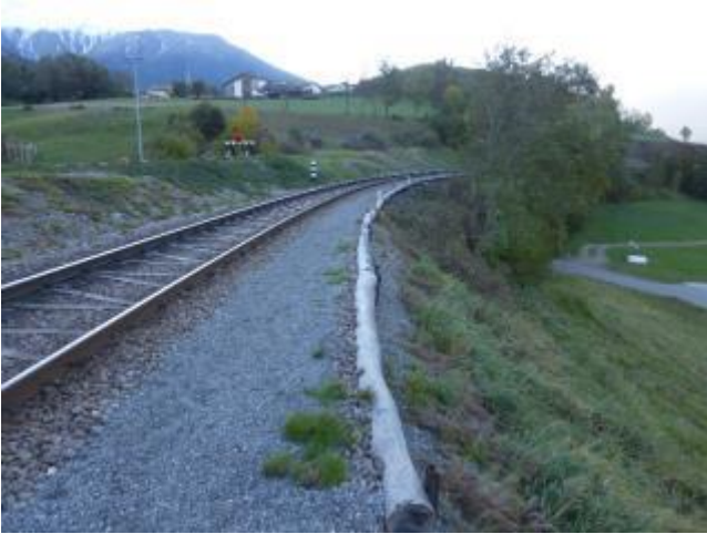
Nella prima parte il tracciato ferroviario si svolge sul versante, a lato valle il terreno è stato riempito.
