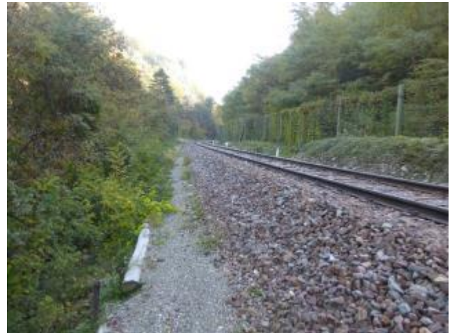
A lato valle scarpata in materiali di riporto.
