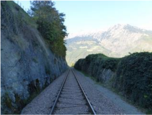
Trasseneinschnitt im Fels (Paragneis) bei ca. km 37,3.
