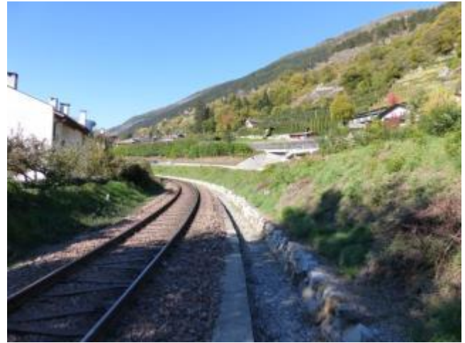
Im Bereich des westlichen Ortsrandes von Schlanders verläuft die Trasse großteils im Einschnitt.
