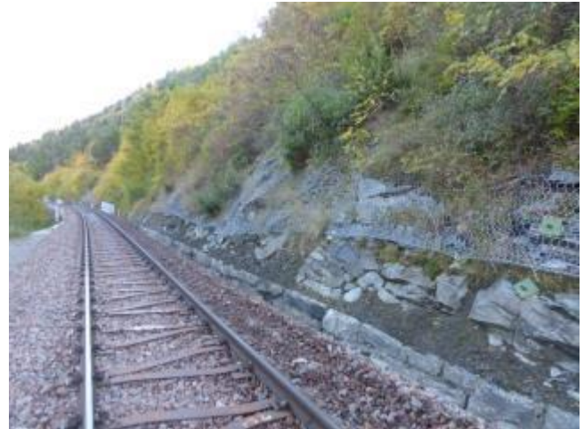
Stark zerlegte Paragneise im Bereich der bergseitigen Anschnittsböschung bei ca. km 67,5.
