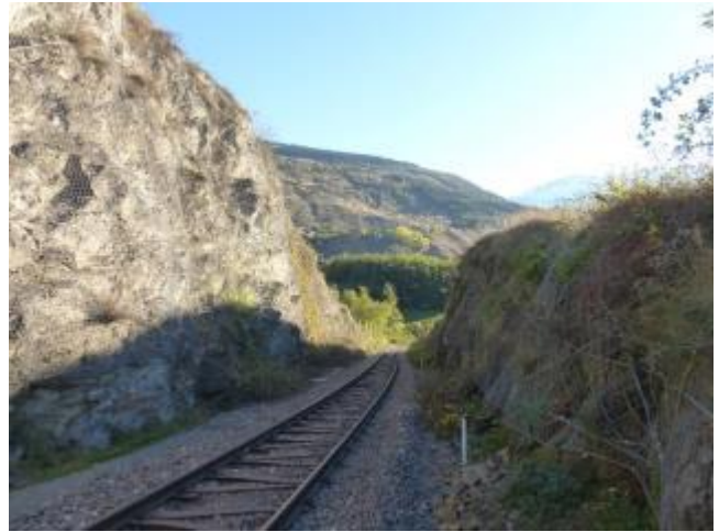
Incisione rocciosa protetta con reti paramassi al km 89,6 ca.
