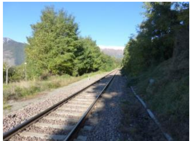
Bergseitig geringe Einschnitte im Hangschutt, talseitig wurde aufgefüllt, Felstiefe nicht bekannt.
