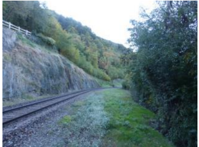
Rilevato al lato valle, costituito prob. da materiale di escavazione da galleria (ca. km 38,3).
