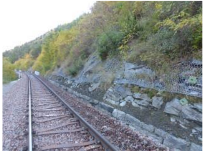
Paragneiss molto fratturati nei pressi del taglio di scarpata al km 67,5 ca.
