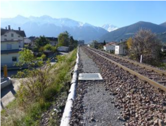
Im Ortsgebiet von Schluderns verläuft die Bahntrasse für rd. 300 m auf einem 7–8 m hohen Damm.
