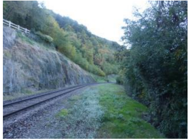
Talseitiger Ausschüttungskörper, vermutlich aus Tunnelausbruchmaterial (ca. km 38,3).
